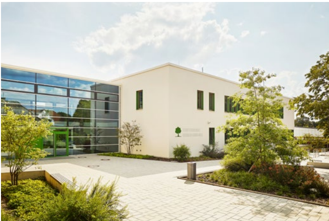
Ein BIM-Beispiel von vielen: Der Umbau und teilweise Neubau der Stadtteilschule am Richard-Linde-Weg.
